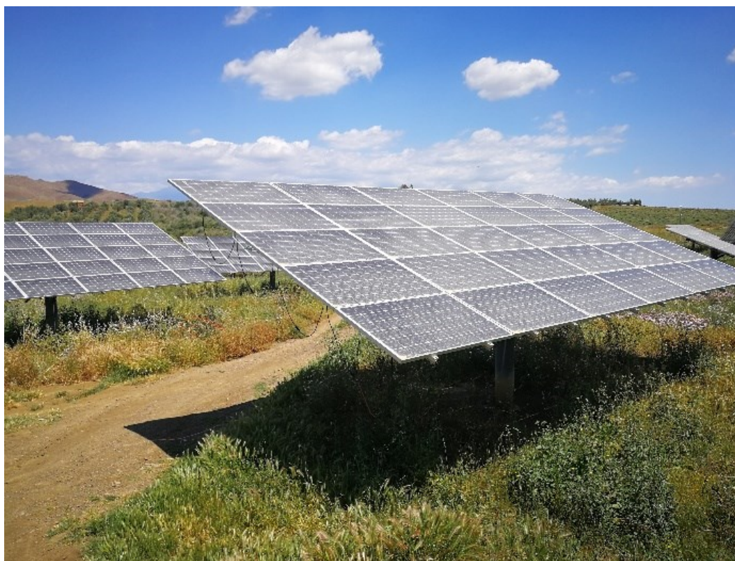
Figura 6 - Inseguitore biassiale "azimut-elevazione"
