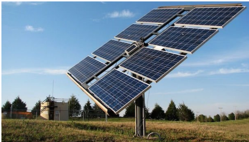
Figura 41 - Inseguitori monoassiali di "azimut"
