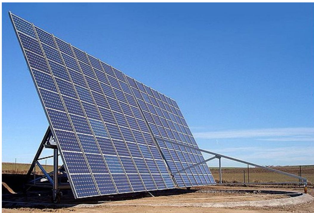
Figura 7 - Inseguitore biassiale "tilt – rollio"
